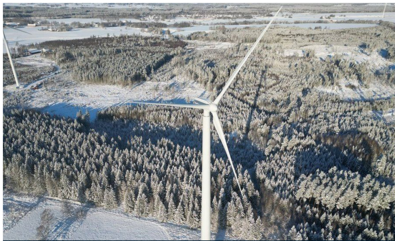
Bild på världens högsta vindkraftverkstorn i trä av Modvion från https://www.bbc.com/news/science-environment-67718719
